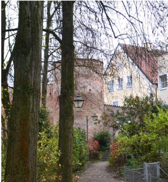
Bild Oben links Stadtmauer, mit gebrannten Ziegeln gemauert Bild Oben rechts Fassadendetail, zu erkennen ist Ziegelmauerwerk
