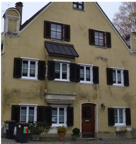
Bild Mitte links Fassade mit Putz und Stuk- katurarbeiten Bild Mitte rechts Fassadendetail links mit Ziegelmauerwerk, rechts mit Fachwerk
