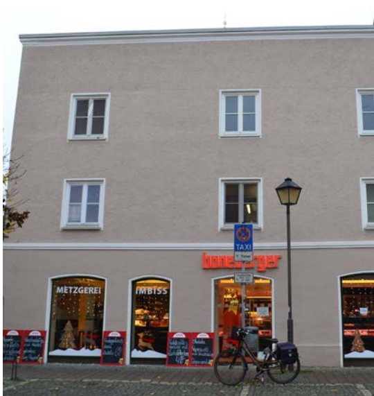
Bild Unten links Gebäude mit Blechdach und entsprechender Traufe Bild Unten rechts Gebäude mit Grabendach (auf dem Bild nur von Außen am Traufabschluss zu erkennen)
