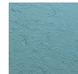
Abbildung 08i (unten) Fassade Detail Foto NAGLIK
