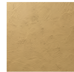
Abbildung 07i (unten) Fassade Detail Foto NAGLIK
