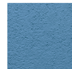
Abbildung 09i (unten) Fassade Detail Foto NAGLIK
