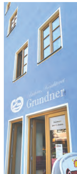
Abbildung 09c (oben) Lange Zeile 16 - Fassaden- detail Foto D I S
