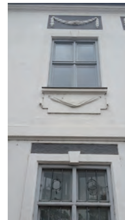
Abbildung 06d (unten) Lange Zeile 6 - Fassadendetail Foto D I S
