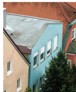
Abbildung 48c (unten) Friedrich-Fischer-Straße 7 - Fassade mit Dach Foto Naglik
