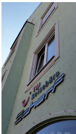
Abbildung 04 d (unten) Lange Zeile 6 - Fassadendetail Foto D I S
