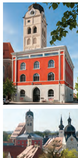
Abbildung 22d (oben) Schrannenplatz 1 - Dachbereich Foto Naglik
