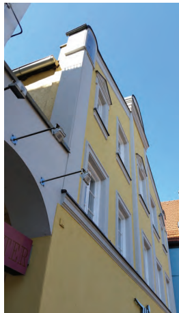
Abbildung 07c (oben) Lange Zeile 12 - Fassaden- detail Foto D I S
